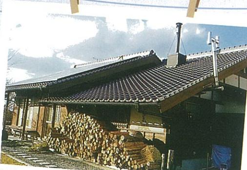
通常よりも屋根が大きく張り出しているので、雨が壁に当たりにくい構造。木の傷みを防いでくれます。
